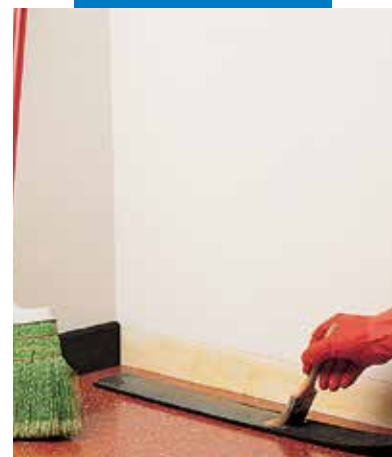
Rozprowadzanie Adesilex VZ na spodniej stronie listwy
