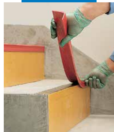
Montaż zwicu stopnia z PVC
