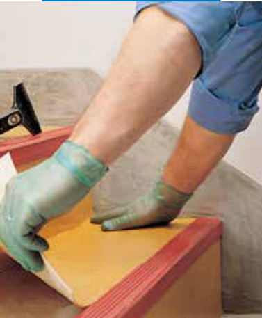
Montaż wykładziny PVC na schodach
