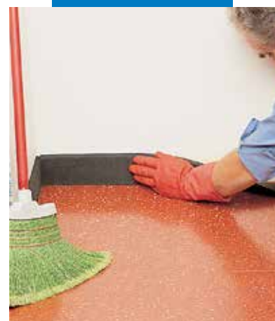
Montaż listwy z PVC
