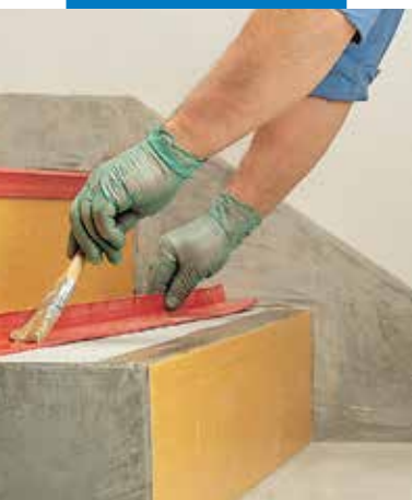
Klejenie wykładziny z PVC na schodach
