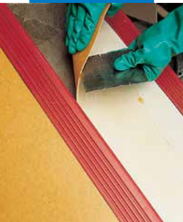
Rozprowadzanie kleju Adesilex VZ na spodzie wykładziny z PVC
