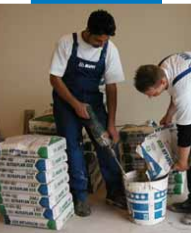
Mieszanie Ultraplan Eco - Ogródek jordanowski Mirabello - Cantù (Como) - Włochy
