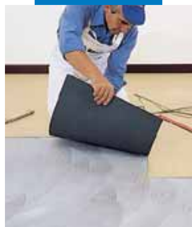
Montaż płytek PCW na klej Rollcoll
