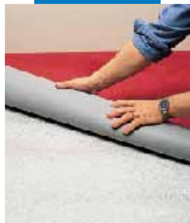
Montaż wykładziny dywanowej
